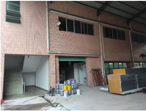
项目厂房外观
