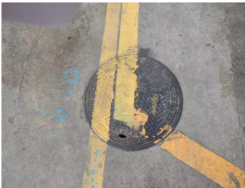
项目雨水井盖
